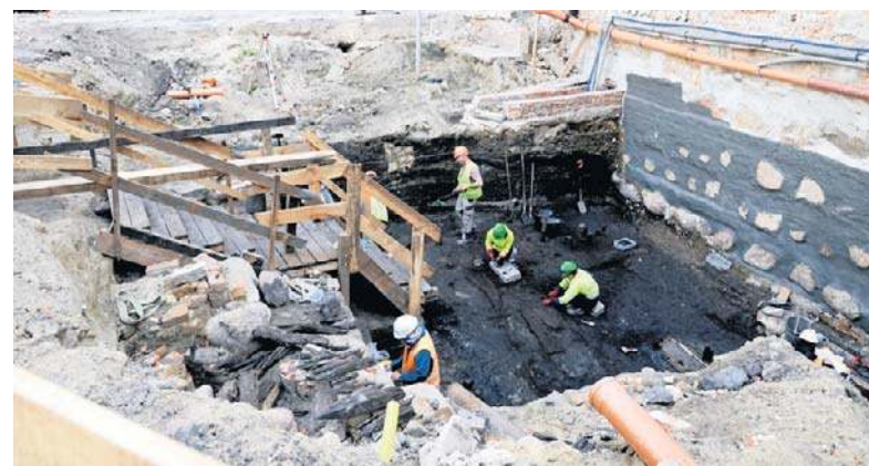
Prace przy modernizacji dziedzińców zajmą 2 lata
