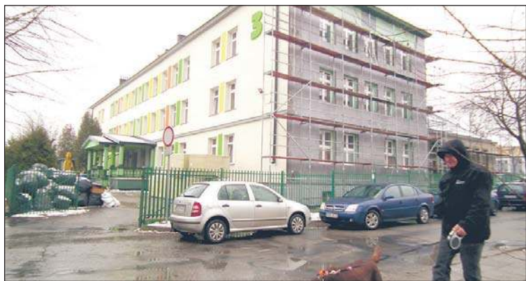
Elewacja frontowa Szkoły Podstawowej nr 3 jest już gotowa. Obecnie trwają prace na pozostałych ścianach.
