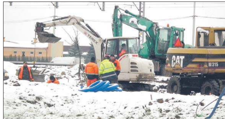
Kolej też nie odpuszcza mimo niepogody. Przy torach niedaleko rampy wciąż widać pracujących robotników.
