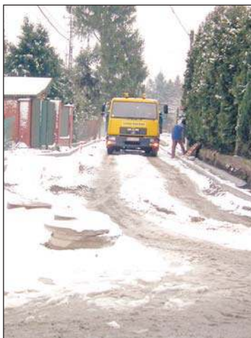
Przebudowa ul. Gawrzyłowskiej.
