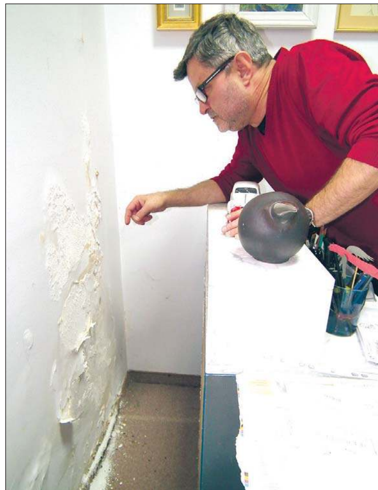
Tuż obok biurka Ryszarda Kucaba efekty zawilgocenia widać aż za dobrze.
