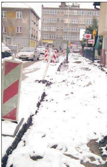
Na Targowej remontowane są chodniki po obu stronach drogi.
