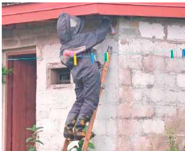
Interwencja przy usuwaniu owadów błonkoskrzydłych w budynku gospodarczym
