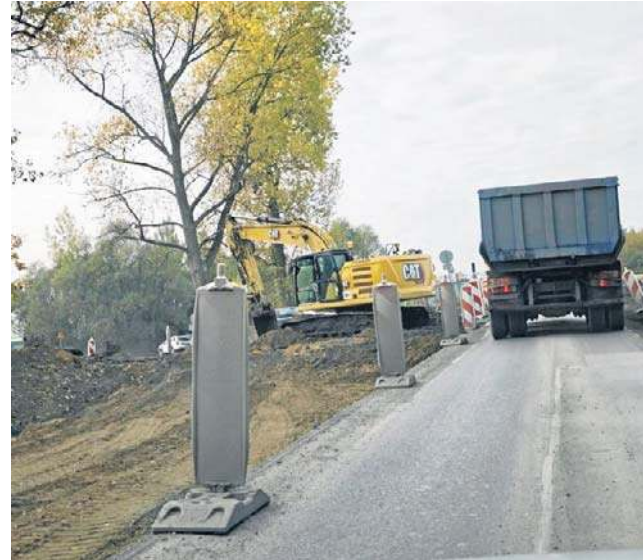
Korki i ruch wahadłowy na DW 781. Trwa tam budowa ronda, które łączyć będzie starą i nową drogę
