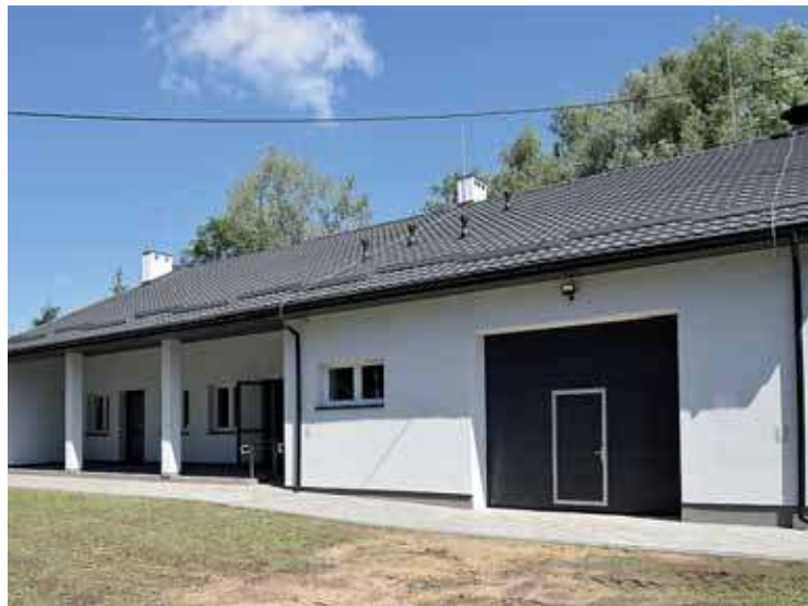
Świetlica wiejska w Strzembowie
