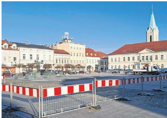
Rozpoczął się remont głównej płyty Rynku, który obejmuje m.in. wymianę nawierzchni
