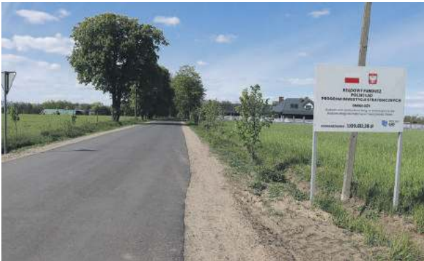
Budowa drogi wewnętrznej w miejscowości Ołdaki
