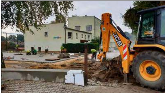
Roboty przy szkole trwają.
