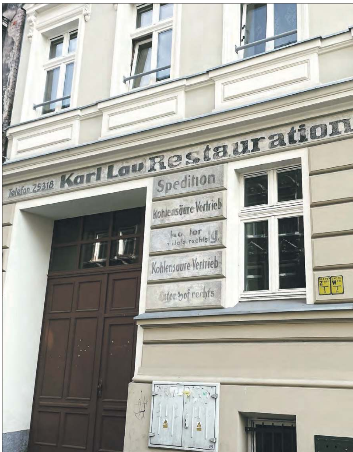
Na odnowionej elewacji starej kamienicy we Wrocławiu zachowano i zakonserwowano pozostałości starych napisów. Dzięki nim wiemy, że w budynku mieściła się kiedyś restauracja oraz spedycja węgla.
