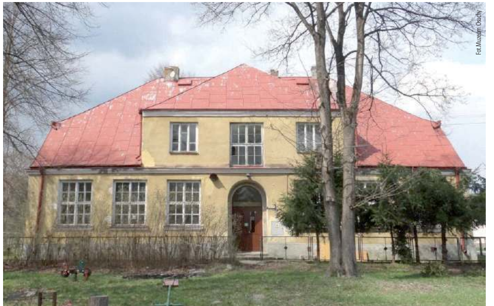
Przebudowa dawnej szkoły w Osuchach pochłonie ponad 12,6 mln złotych
