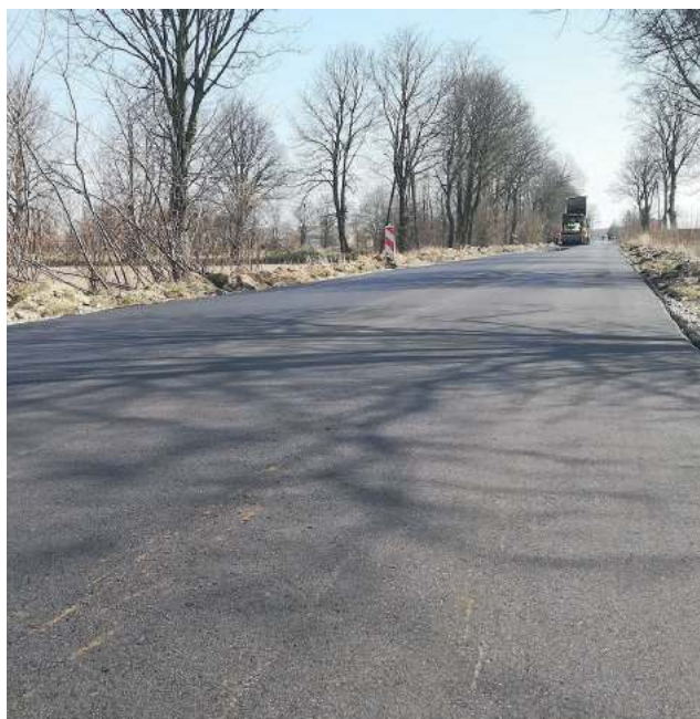
Parczewskie PRDM remontuje 433 metry drogi
