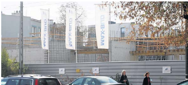
Inwestycja przy Kunickiego będzie kosztować 73,6 mln zł. Zakończenie prac budowlanych planowane jest na maj 2028 roku
