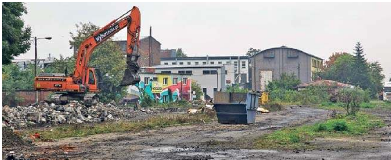
Na przebudowywanym terenie powstanie droga i m.in. ok. 100 miejsc parkingowych
