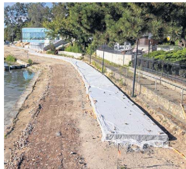
Powstają kolejne elementy placu zabaw, trybuny przy przyszłym boisku do siatkówki plażowej, schody i ścieżka wzdłuż plaży.
