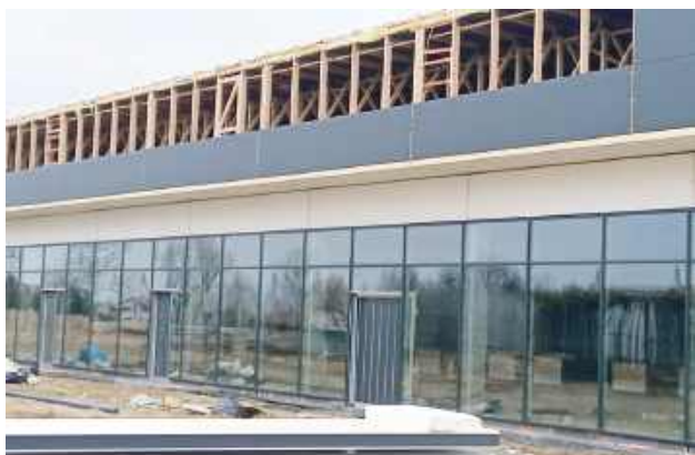
Trwają prace także na pierwszym piętrze nowej galerii
