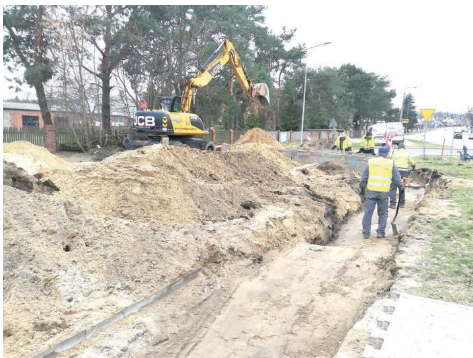
Roboty przy ul. Radomskiej w Górze Puławskiej powoli dobiegają końca. Już niedługo prace przeniosą się na teren Sadłowic
