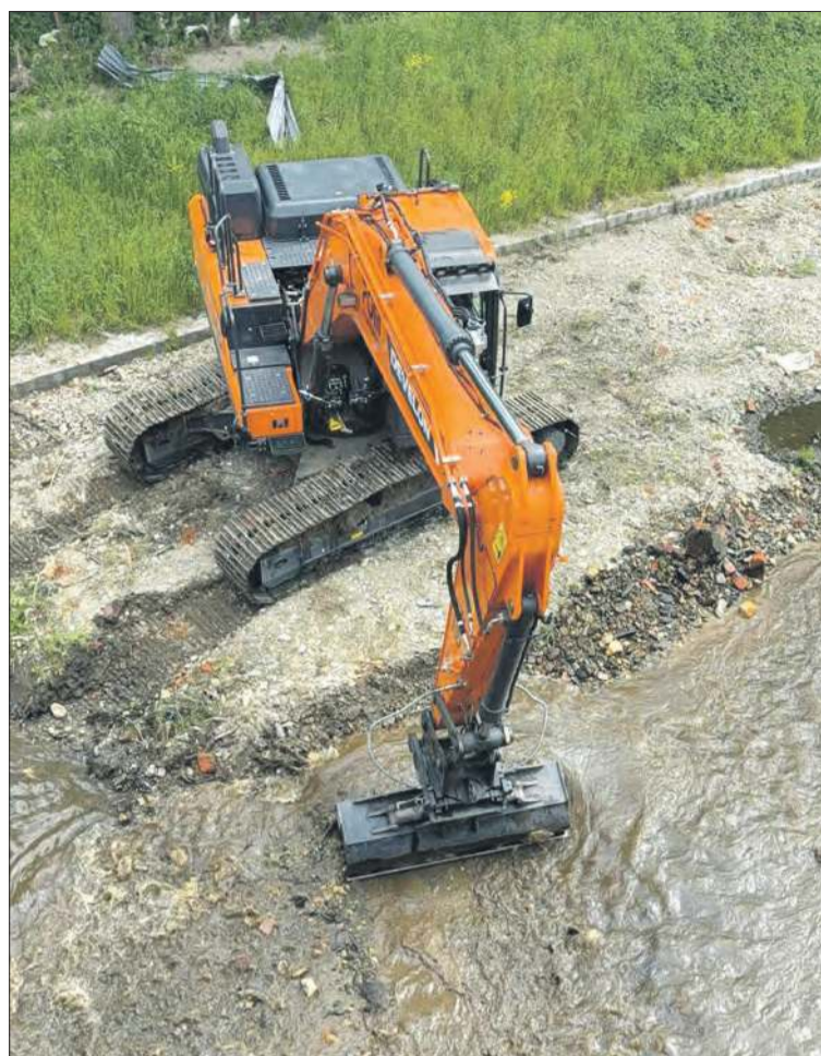
Prace na Złotym Potoku w Prudniku
