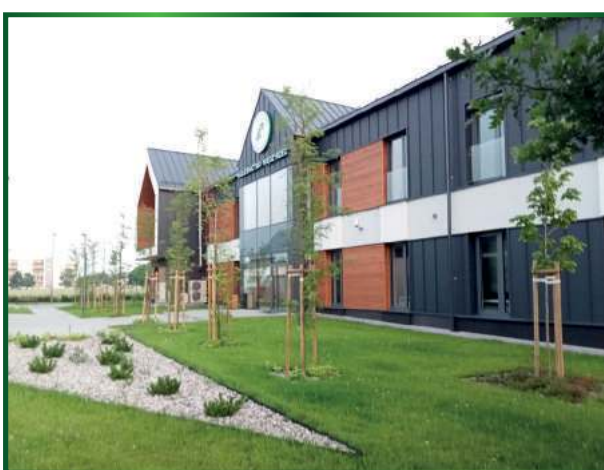
Nowa siedziba Nadleśnictwa Międzyrzec przy Leśnej 8
