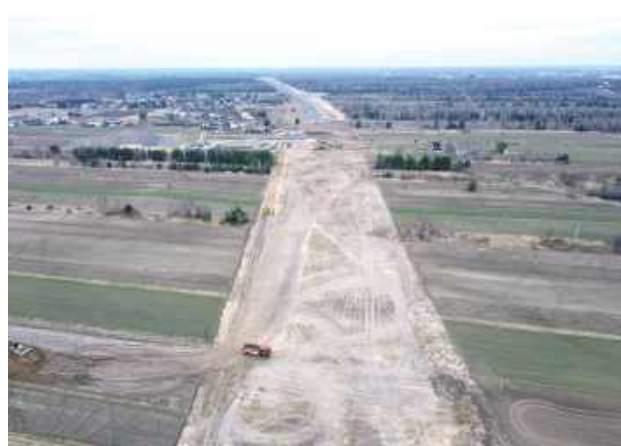
Budowa S19 Lubartów - Lublin. Marzec 2025 r.
