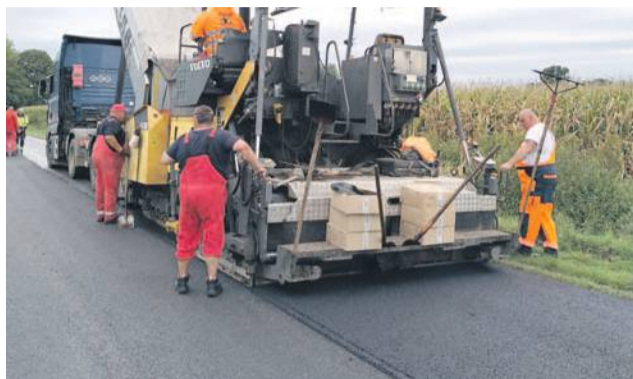
Prace nad nową nawierzchnią
