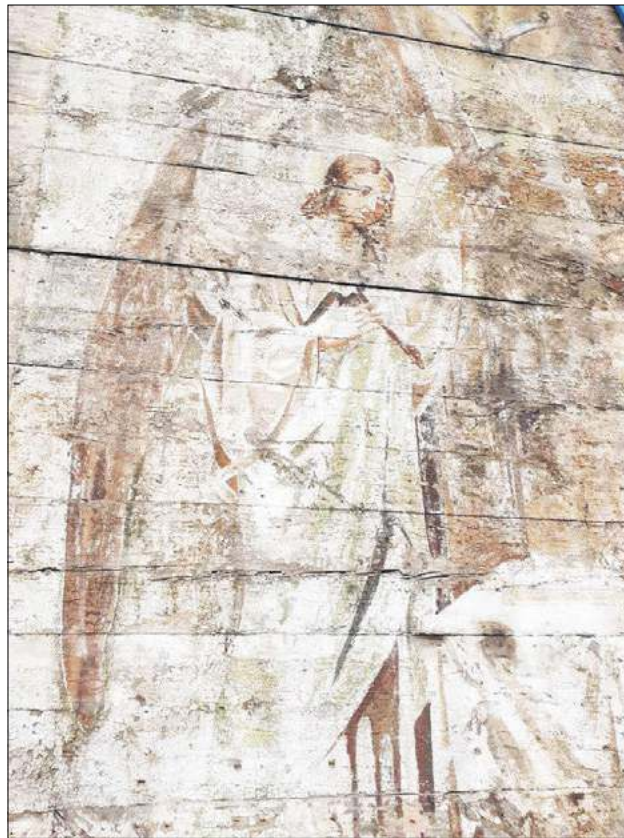
Polichromia była ukryta od 1945 r. – Była przykryta szalunkiem, dopiero podczas remontu w zeszłym roku udało się ją odnaleźć – przekazuje konserwator zabytków
