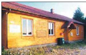
Modernizacja polegała na obiciu zewnętrznych ścian świetlicy oraz wykonaniu elewacji podmurówki
