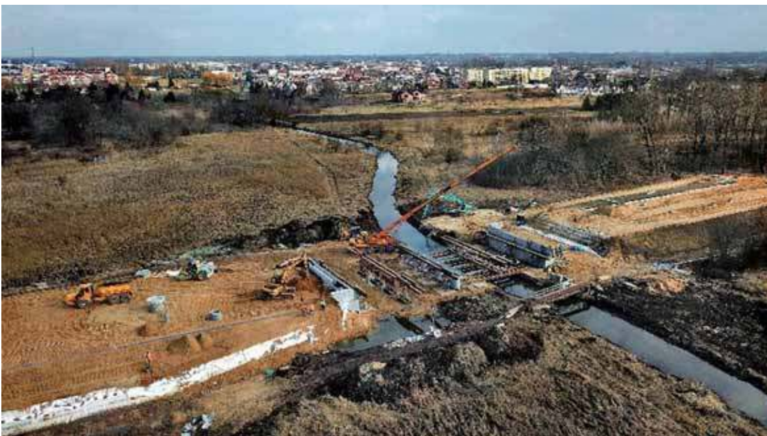
Fragment budowanej płońskiej obwodnicy z lotu ptaka
