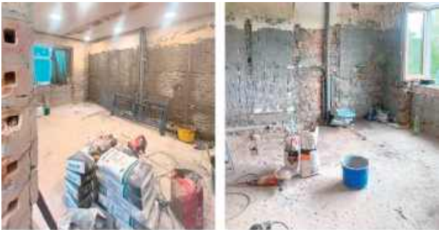
W ramach remontu zaplanowano m.in. wymianę pionów i poziomów kanalizacji sanitarnej, armatury sanitarnej, w tym pryszniców, zlewów i urządzeń sanitarnych, a także kabin, drzwi oraz płytek. Łazienki zostaną również dostosowane do potrzeb osób z niepełnosprawnościami (fot. Powiat Rycki-Starostwo Powiatowe w Rykach)
