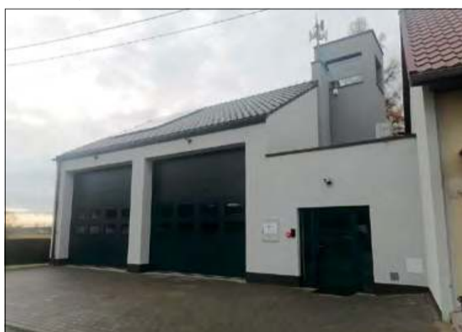
Finalnie nowa część remizy obejmuje garaż dwustanowiskowy na wozy bojowe, pomieszczenie gospodarcze, toalety oraz tunel na węże.
