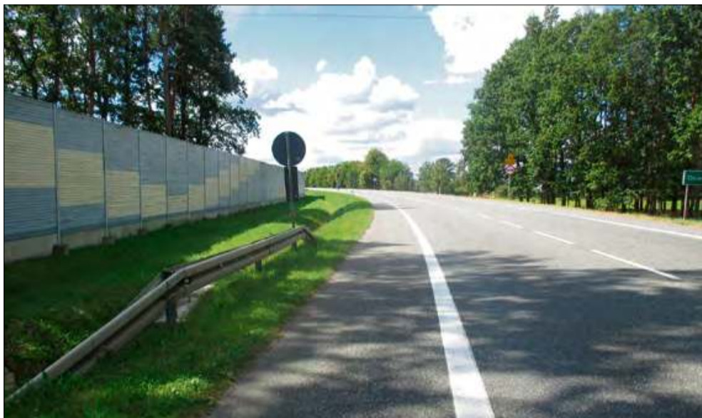
Budowa ścieżki pieszo-rowerowej będzie kosztować niespełna 9 mln 100 tys. zł.
