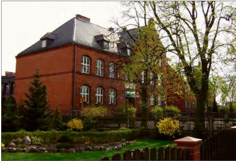
W 2026 roku modernizację przejdzie Publiczna Szkoła Podstawowa w Popielowie.
