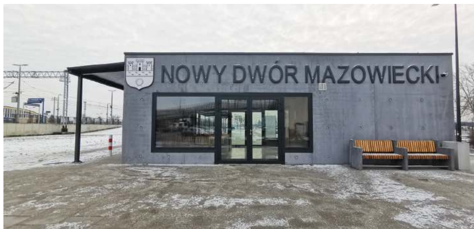
Minimalistyczny w formie architektonicznej (i nie tylko) budynek poczekalni
