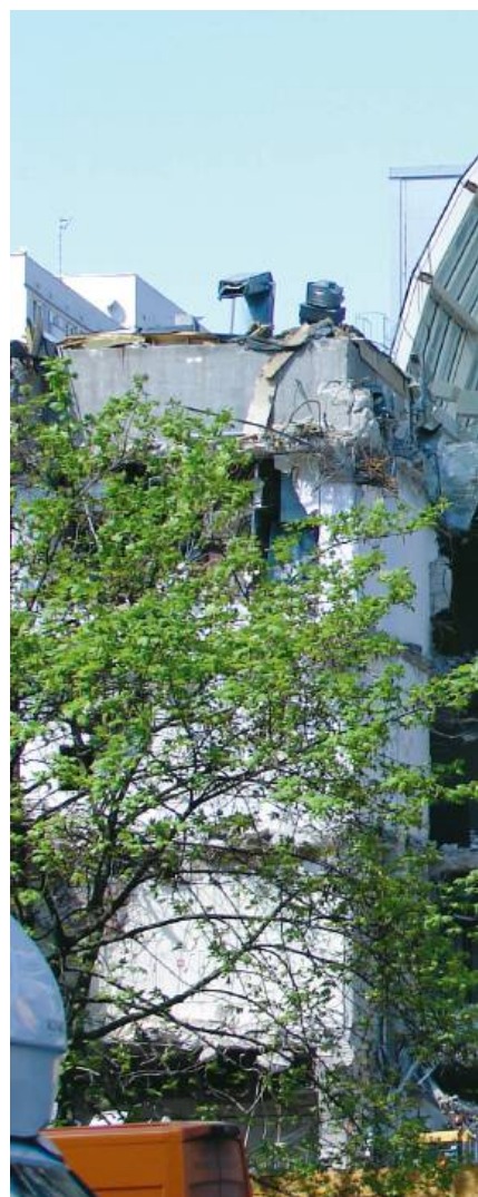
Rozbiórka biurowca Atrium International | fot. Janusz Sujecki
