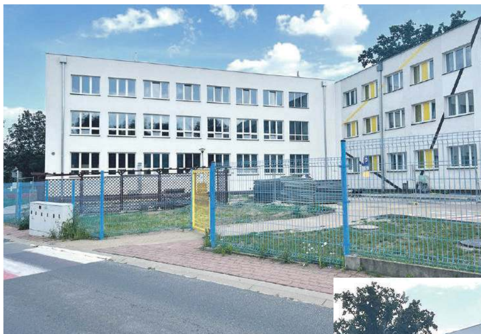
Nowe skrzydło szkoły nie ma osobnej klatki ewakuacyjnej
