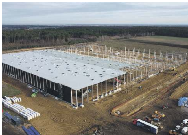
W Korzeńsku powstaje centrum logistyczne
