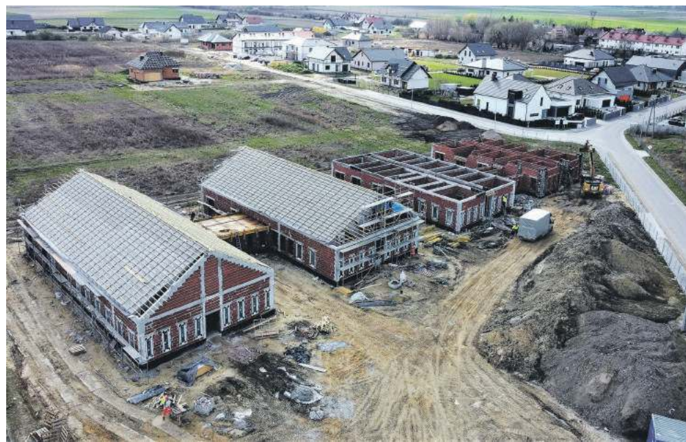
Budowa centrum opiekuńczo - mieszkalnego
