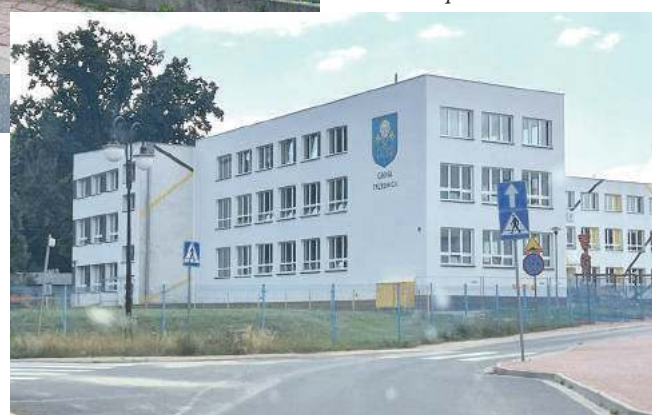
W dobudowanym skrzydle szkoły nie ma toalet
