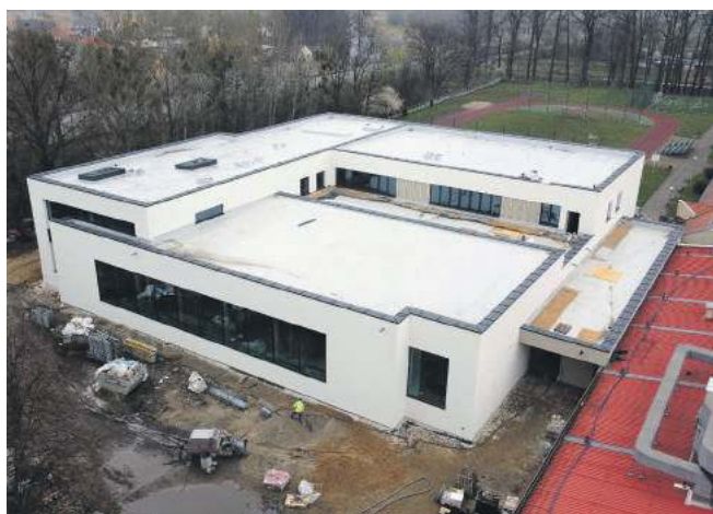
Budowa basenu przy szkole podstawowej w Żmigrodzie
