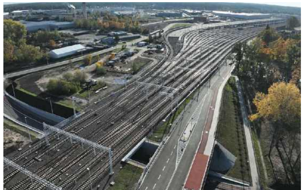
Nowe wiadukty w Ełku
