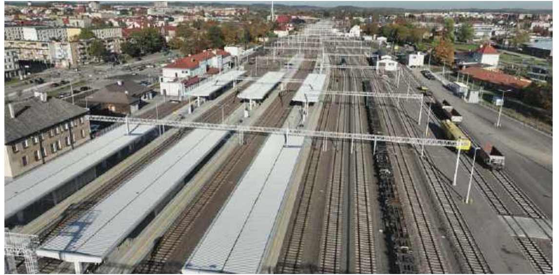
Zmodernizowana stacja Ełk
