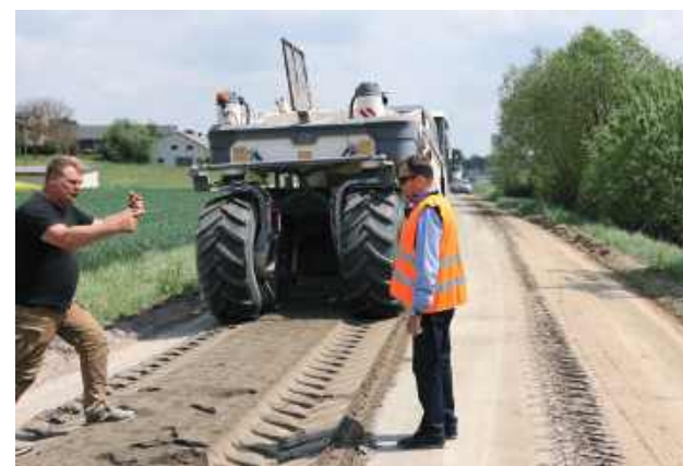
Wyremontowany zostanie czterokilometrowy odcinek
