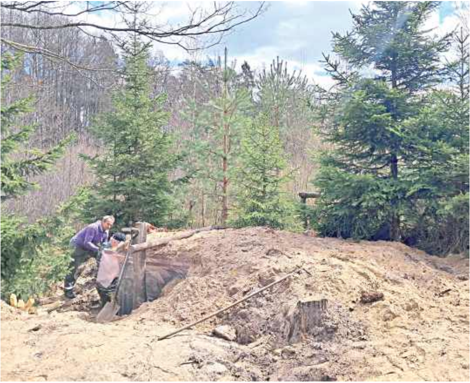
Bunkier w trakcie rekonstrukcji
