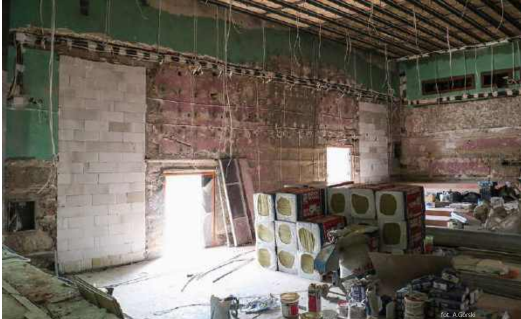
Remont UDK rozpoczął się od sali widowiskowo-kinowej.
