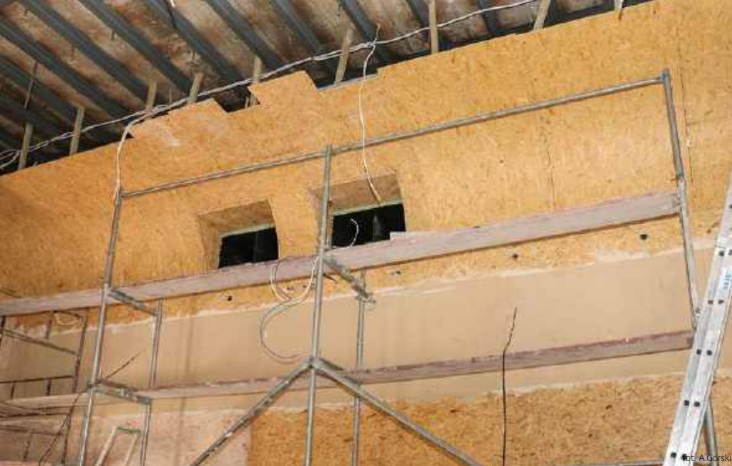
Tylna ściana w górnej części przechodzi łagodnie, w formie łuku, w sufit podwieszony.
