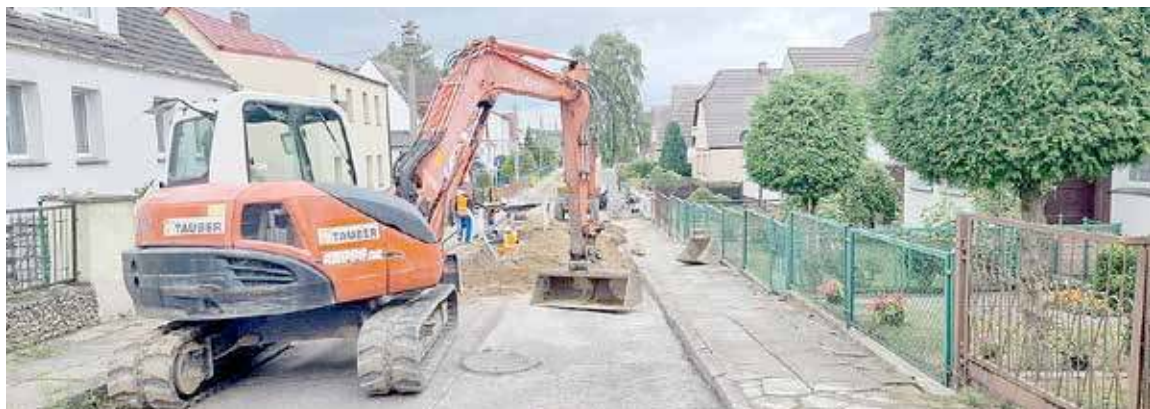
Prace trwać będą na całej długości ulicy Kilińskiego
