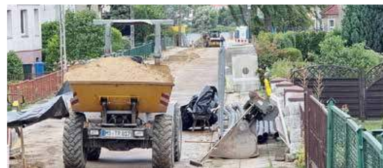
Na miejscu pracuje już ciężki sprzęt
