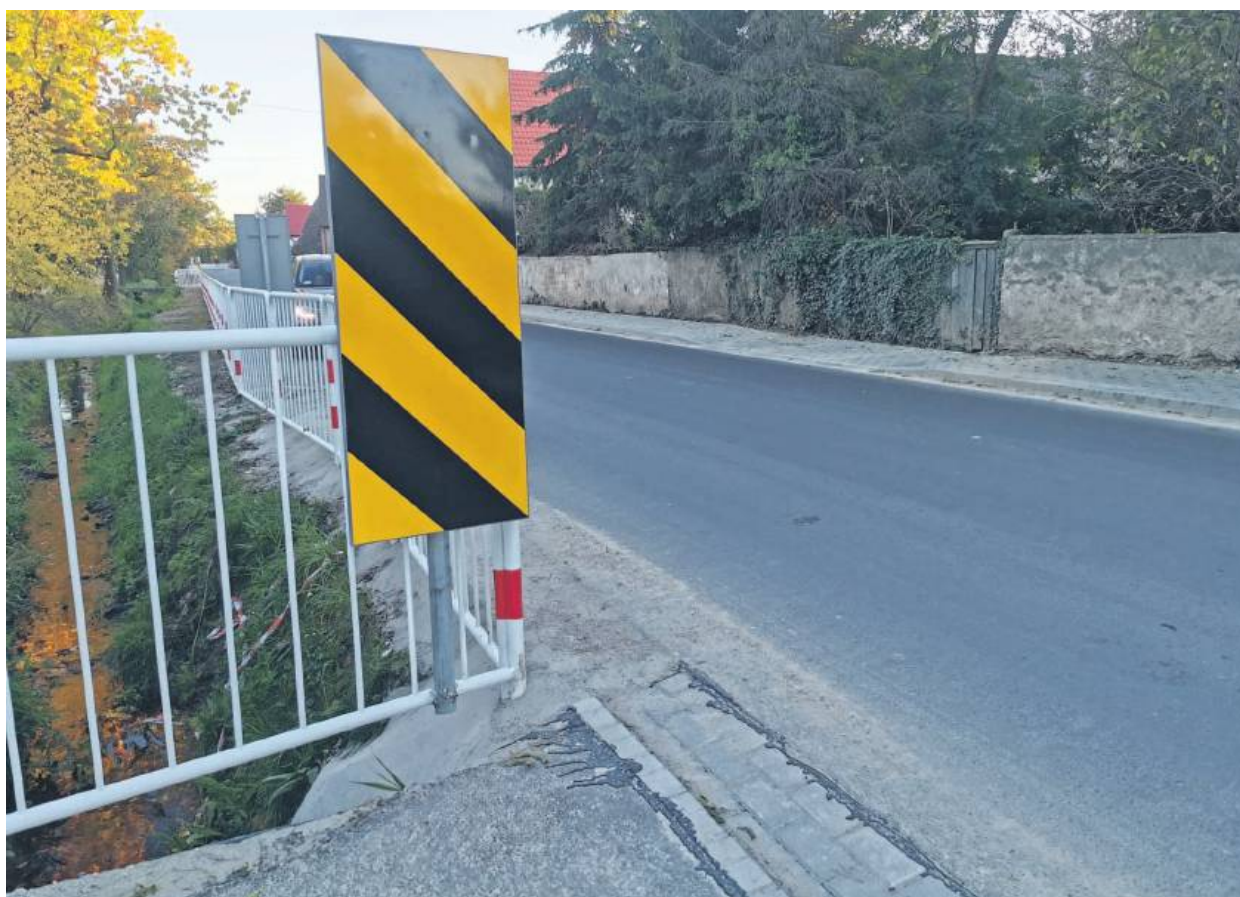
Znaki przymocowane nisko na barierkach skutecznie ograniczają widoczność w lewo osobom wyjeżdżającym z tej drogi. Mniej wnikliwych informujemy, że właśnie z lewej strony schowany jest nadjeżdżający samochód (widać tylko jego fragment)
