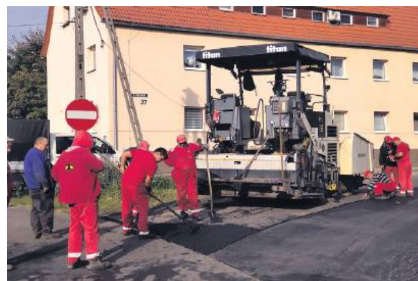
Ostatnie prace na remontowanej ulicy w Przewornie...
