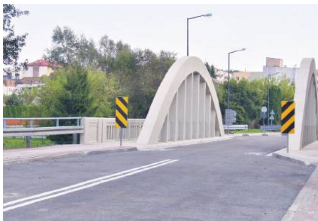
Remont mostu kosztował ponad 1 mln zł.
