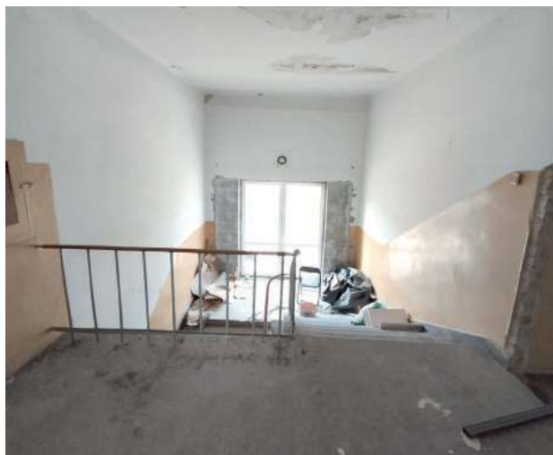
Dawny internat w Turobinie to wielki plac budowy
