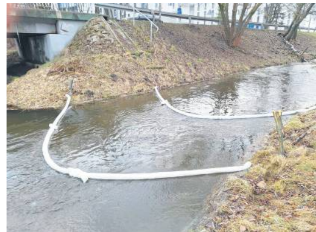
Strażacy rozstawili dwa rzędy zapór sorpcyjnych, które zbierały substancję z powierzchni. Fot. Straż Pożarna
