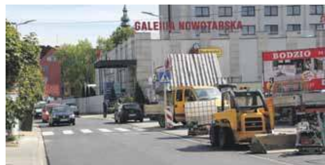
Ul. Królowej Jadwigi z nową nawierzchnią.
