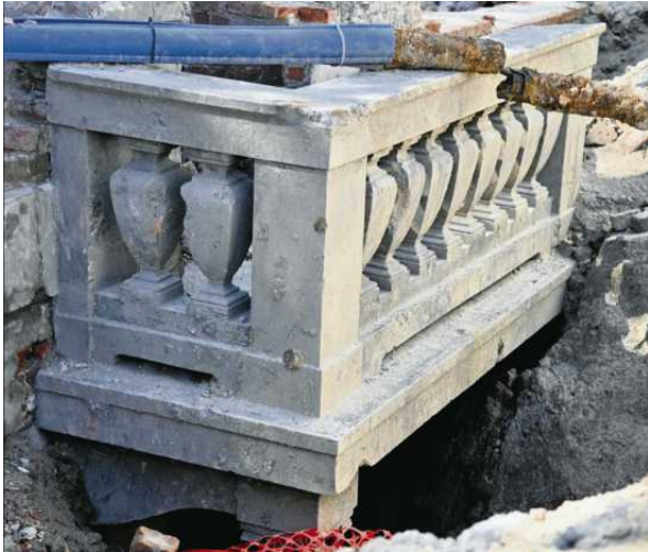
• Odkopany balkon kamienicy przy ul. Nowy Zjazd 5 FOT. WOJEWÓDZKI URZĄD OCHRONY ZABYTKÓW W WARSZAWIE / FACEBOOK
