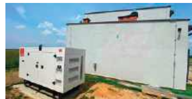
Trwa przebudowa stacji w Cholewach
