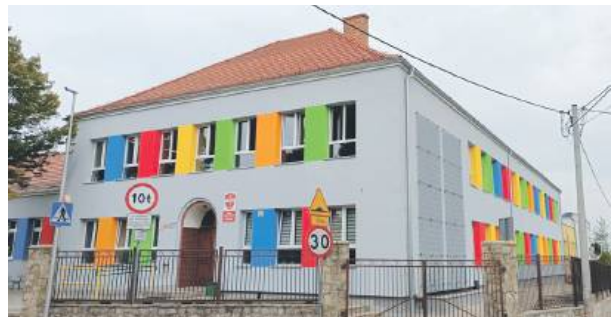
W budynku szkoły w Prusach wymieniono okna, wykonano nową elewację i ocieplenie, a także zamontowano nowy kocioł olejowy i ocieplono poddasze
