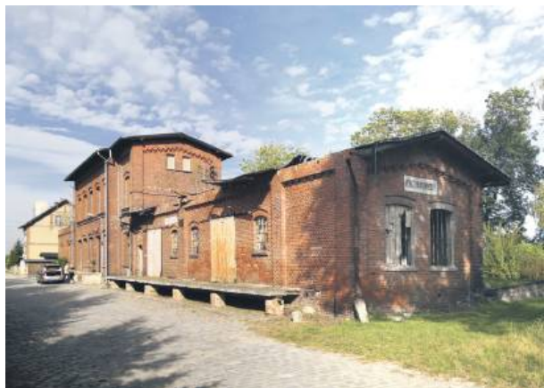
Remont budynku po byłej stacji PKP w Kondratowicach będzie kosztował niespełna 1 mln zł
