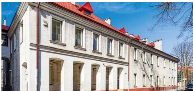
OKOLICE OPOLA | 1 600 000 zł 3-kondygnacyjna kamienica (2 173 m 2 ) w centrum. Tel. +48 883 377 590 SO188-11217
