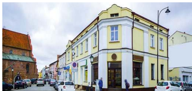
KONIN | 6 900 000 zł 2 przylegające kamienice (500 m 2 ) w ścisłym centrum. Tel. +48 601 842 200 SO205-668
