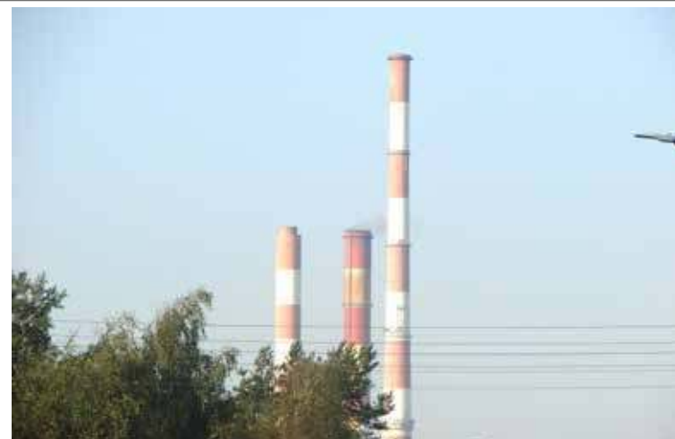
Kominy Dolnej wieczorem. Pracuje już pierwszy blok gazowy
