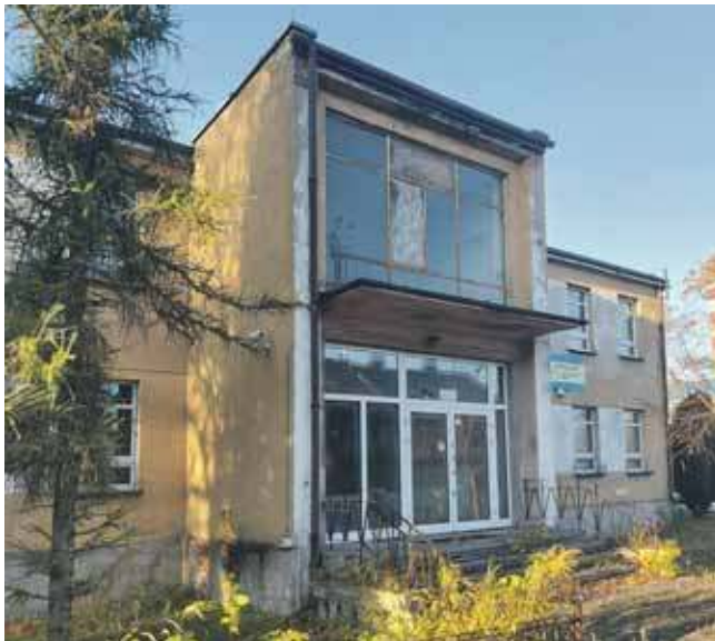
Powiat chce wyburzyć budynki zajmowane kiedyś przez szkołę i w jej miejsce wybudować DPS
