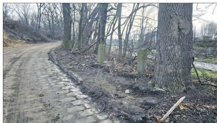
Stare, kamienne słupy drogowe. Warto je zachować.
