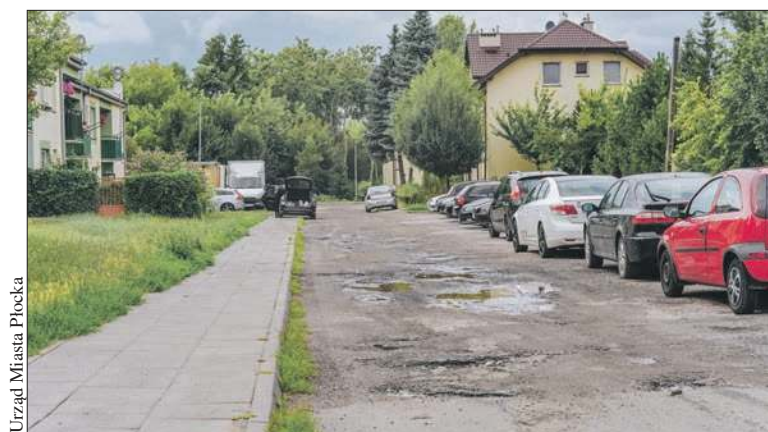
Na osiedlu powstaną nowe drogi
