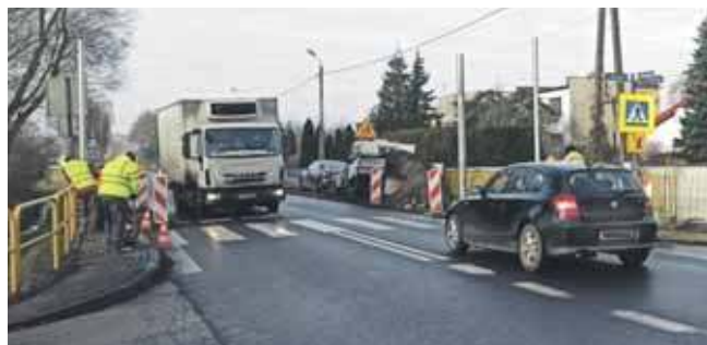
Budowa sygnalizacji świetlnej na DK 78 w Świerklańcu
