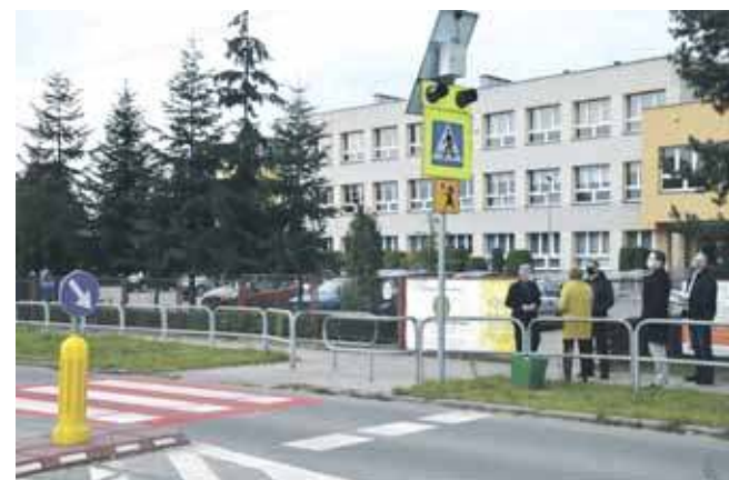
Najwięcej przejść powstało przy szkołach
