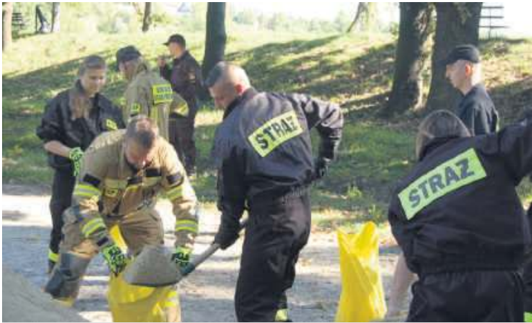
Strażacy układali worki z piaskiem, aby zabezpieczyć koronę wału
