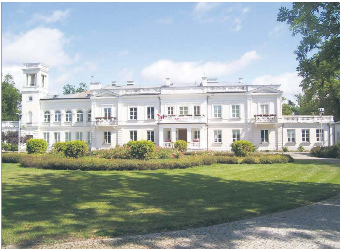
Elewacja frontowa pałacu Prusaków w Sannikach
