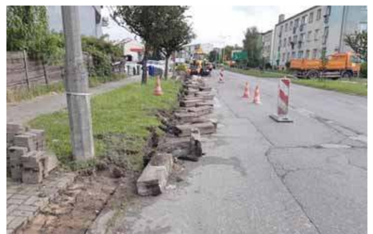
Wymiana krawężników na ul. Grzebskiego
