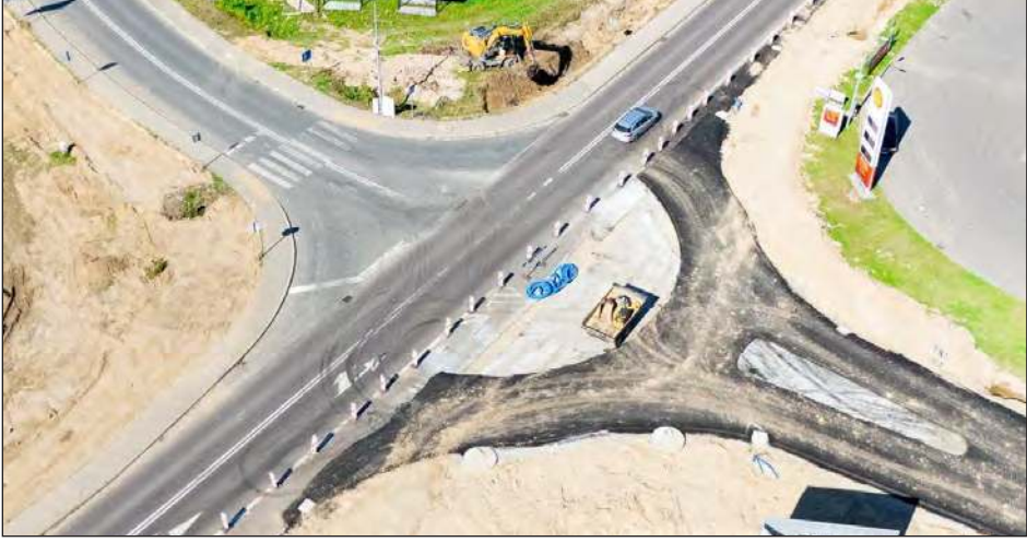
» Na placu budowy widać już pierwsze konkretne efekty prac, a cała inwestycja ma być gotowa przed listopadem 2025 roku
