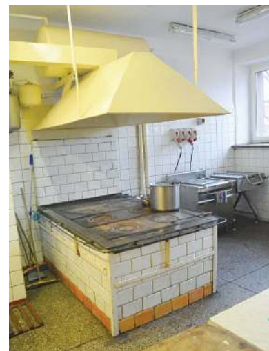
Stan przed modernizacją
