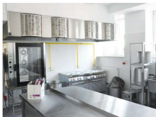
Stan po modernizacji
